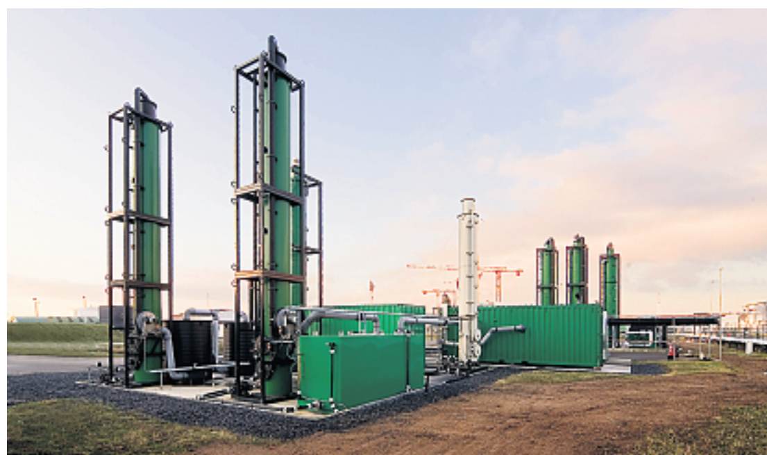
Installatie voor de sanering van een omvangrijke olie verontreiniging.
